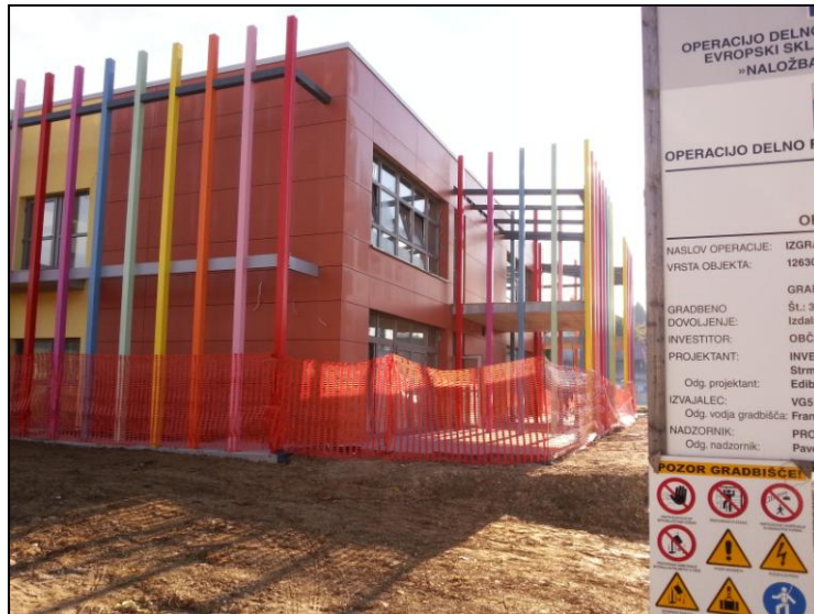
Slika 18: Gradnja novega nizkoenergetskega vrtca Benedikt
