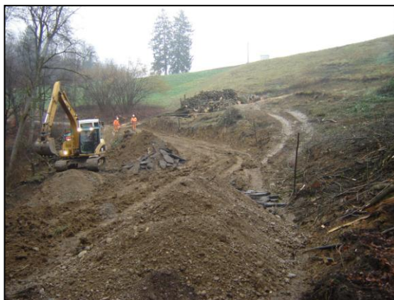
Slika 14: Sanacija plazu v Ihovi
