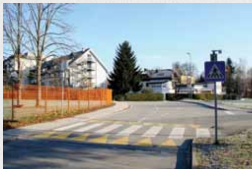
Po izvedbi ukrepa
