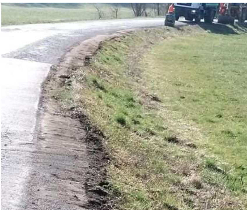
Slika 7: Vzdrževanje bankin ob občinski cesti
