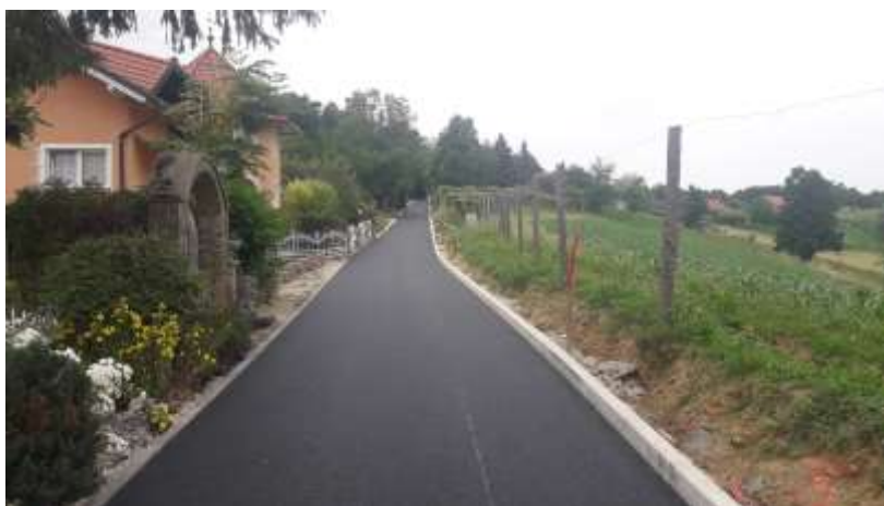
Slika 9: Obnovljen del vozišča na JP 704871
