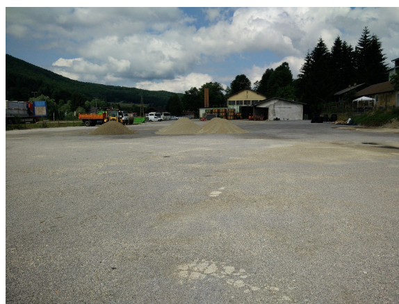
Potencial za razvoj parkirišča na prostoru bivše komunale, ki bi omogočal parkiranje večjega števila zaposlenih.
