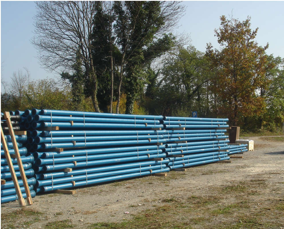
Gradnja vodovoda Sinji Vrh
