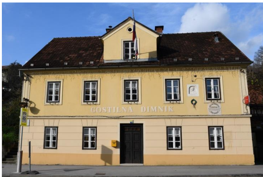
Fototeka ZVKDS, OE Celje, foto N. Podkrižnik (2019)
