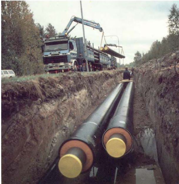
Slika 16.21.3: Vgradnja vročevoda iz predizoliranih cevi
