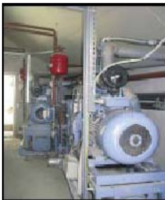
Slika 16.18.2: Prvi primer izrabe bioplina v namene proizvodnje električne energije v Sloveniji; sistem SPTE ter črpalni jašek in fermentorja
