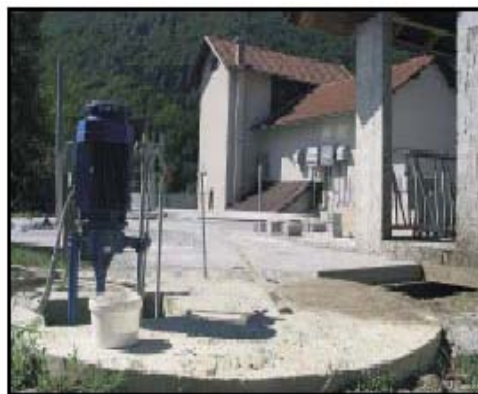
Slika 16.18.2: Prvi primer izrabe bioplina v namene proizvodnje električne energije v Sloveniji; sistem SPTE ter črpalni jašek in fermentorja
