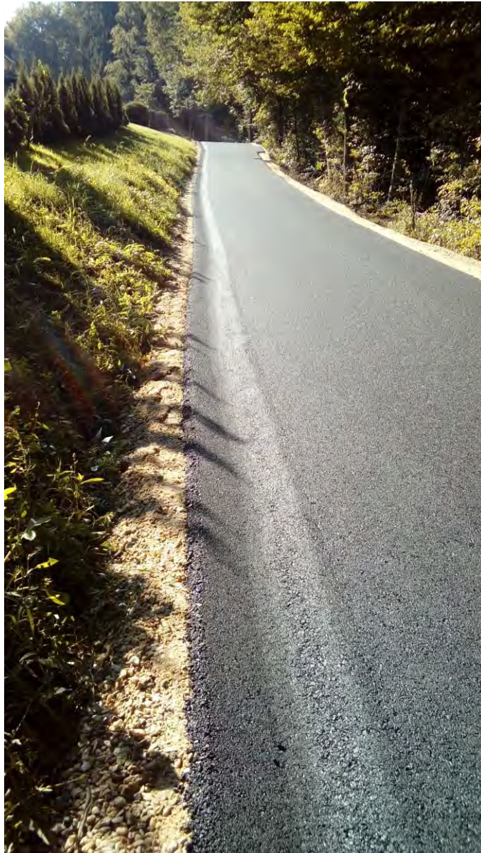
Slika 7: Obnovljen del vozišča
