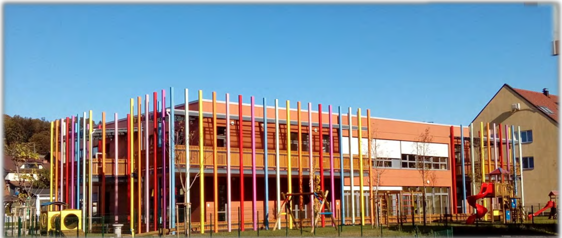
Slika 8: Novi nizkoenergetski vrtec Benedikt
