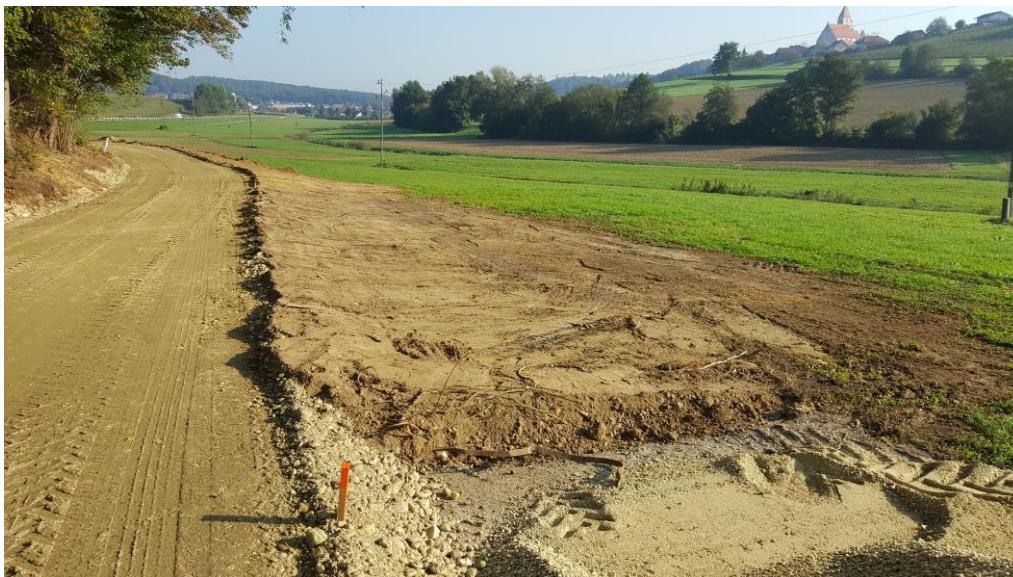
Slika 8: Gradbena dela na cesti JP 704851
