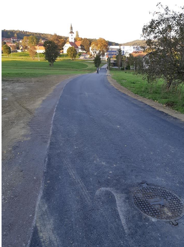
Slika 7: Obnovljen del vozišča JP 704961
